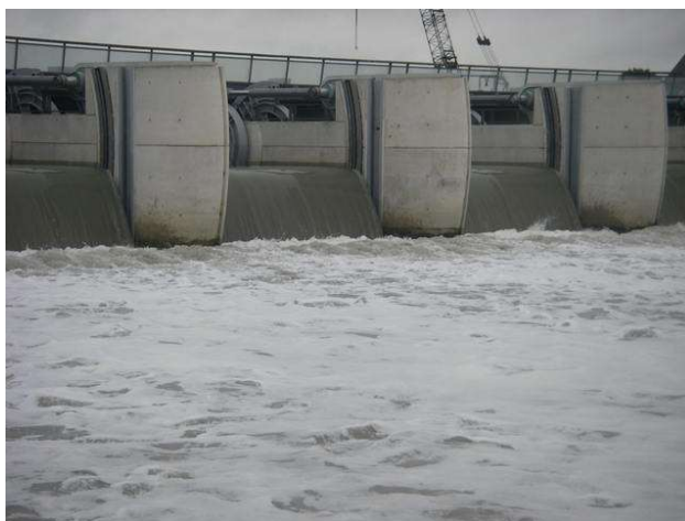
Figure 9. Au jusant, les vannes du barrage de la Caserne sont ouvertes ; l'eau stockée est déversée progressivement dans la baie du Mont Saint-Michel.
