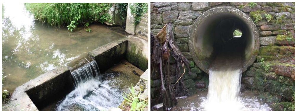
Figure 6 : Exemples d'ouvrages empêchant la continuité écologique des cours d'eau fréquemment retrouvés dans la Manche (buse à droite et seuil à gauche).
